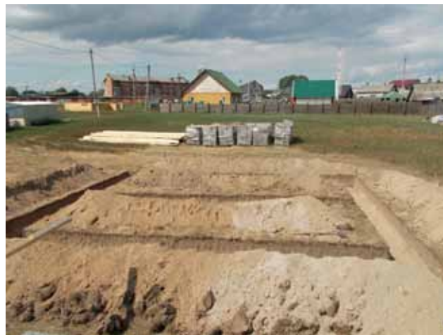
Отличный грунт для заложения мелкозаглубленного фундамента
