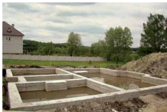
Типичный случай – глина. Ленточный фундамент нужно заглубить ниже уровня промерзания земли
