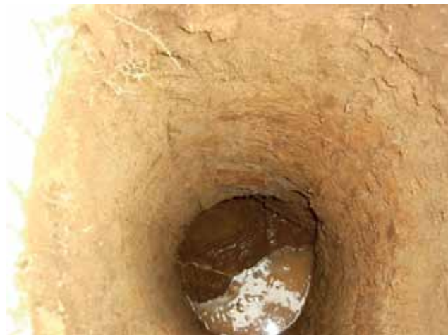
Сложный случай: песок-«плывун», высокие грунтовые воды
