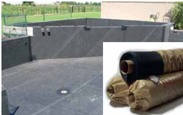
Гидроизоляция с помощью EPDM мембраны Firestone
