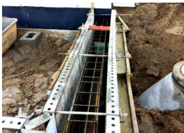
Для ленточного фундамента проще использовать съемную опалубку
