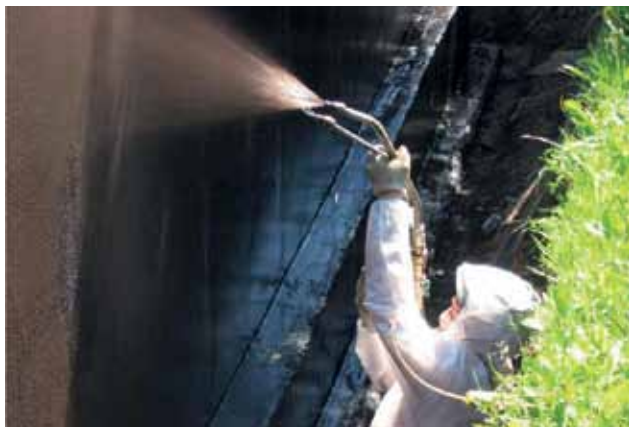
Битумная гидроизоляция
