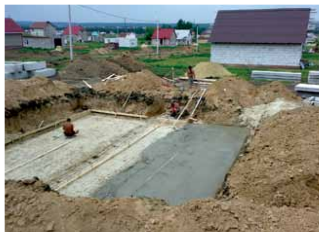
Плитный фундамент. Просадочный грунт основания заменили на крупный гравий
